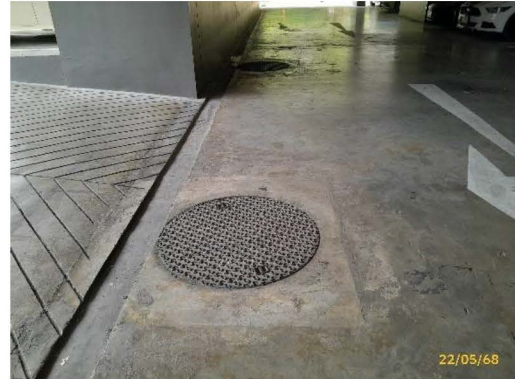
ฝาปิดถังเก็บน้ำชั้นใต้ดิน และมิเตอร์น้ำประปาด้านหน้าโครงการ
